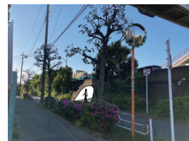
多摩川沿線道路、堤防下を貫く歩行者専用トンネルによって、河川敷へのアクセス向上を図る
