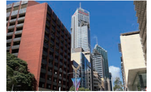
建築物の高さの統一感がない
