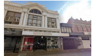
片側式アーケードが設置されている
