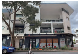
2階以上の建物の壁面に設けられたテラス
