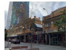
【2-6 Perth ショッピングセンターエリア】 1階に店舗、2階に住宅の建築
